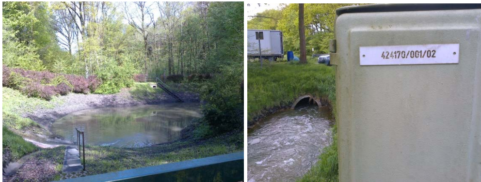
Abbildung 13: Grubenwassermessstelle und Einleitung aus dem Oeynhaus-Stollen, Foto LANUV
