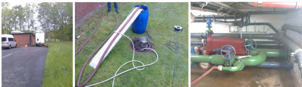
Abbildung 24: Grubenwassermessstelle und Einleitung aus dem Dickenberger Stollen und den Bockenrader Stollen, Foto LANUV
