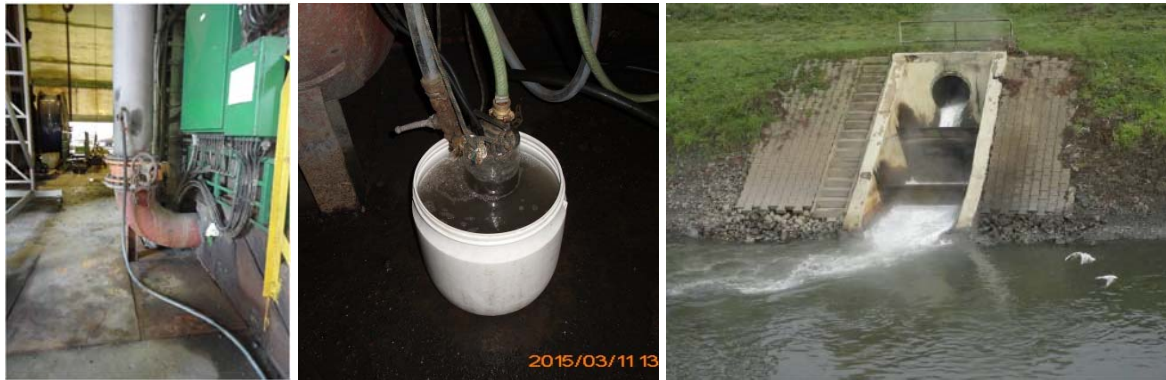
Abbildung 33: Grubenwassermessstellen, Zentrifugenprobenahme und Einleitung Zeche Prosper Haniel, Fotos LANUV und RAG (Einleitung)
