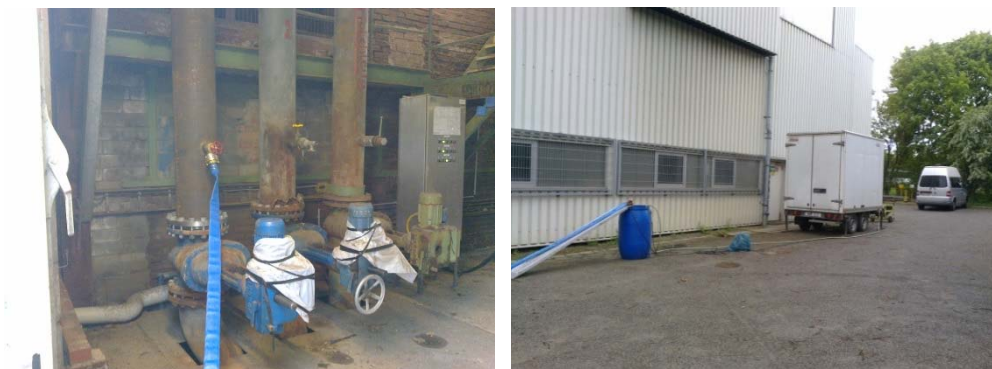
Abbildung 49: Grubenwassermessstellen und Zentrifugenprobenahme Zeche Concordia, Fotos LANUV
